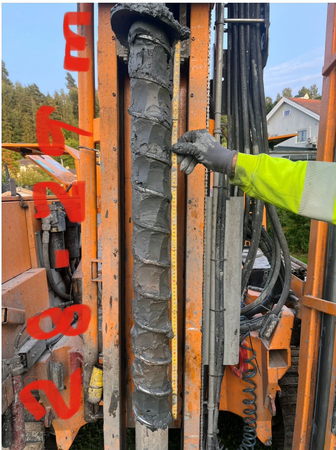
Figur D 12: Skovlboring ved 28-29 meters dybde i borpunkt 2A
