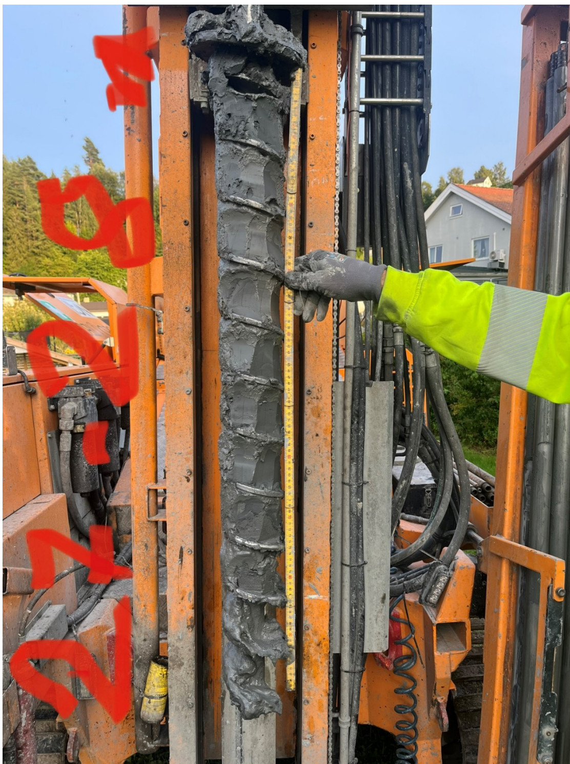
Figur D 11: Skovlboring ved 27-28 meters dybde i borpunkt 2A
