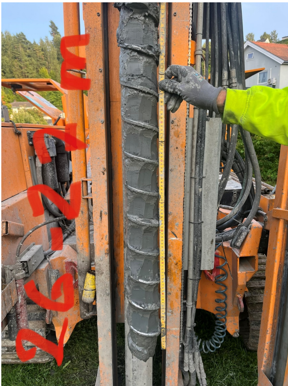
Figur D 10: Skovlboring ved 26-27 meters dybde i borpunkt 2A
