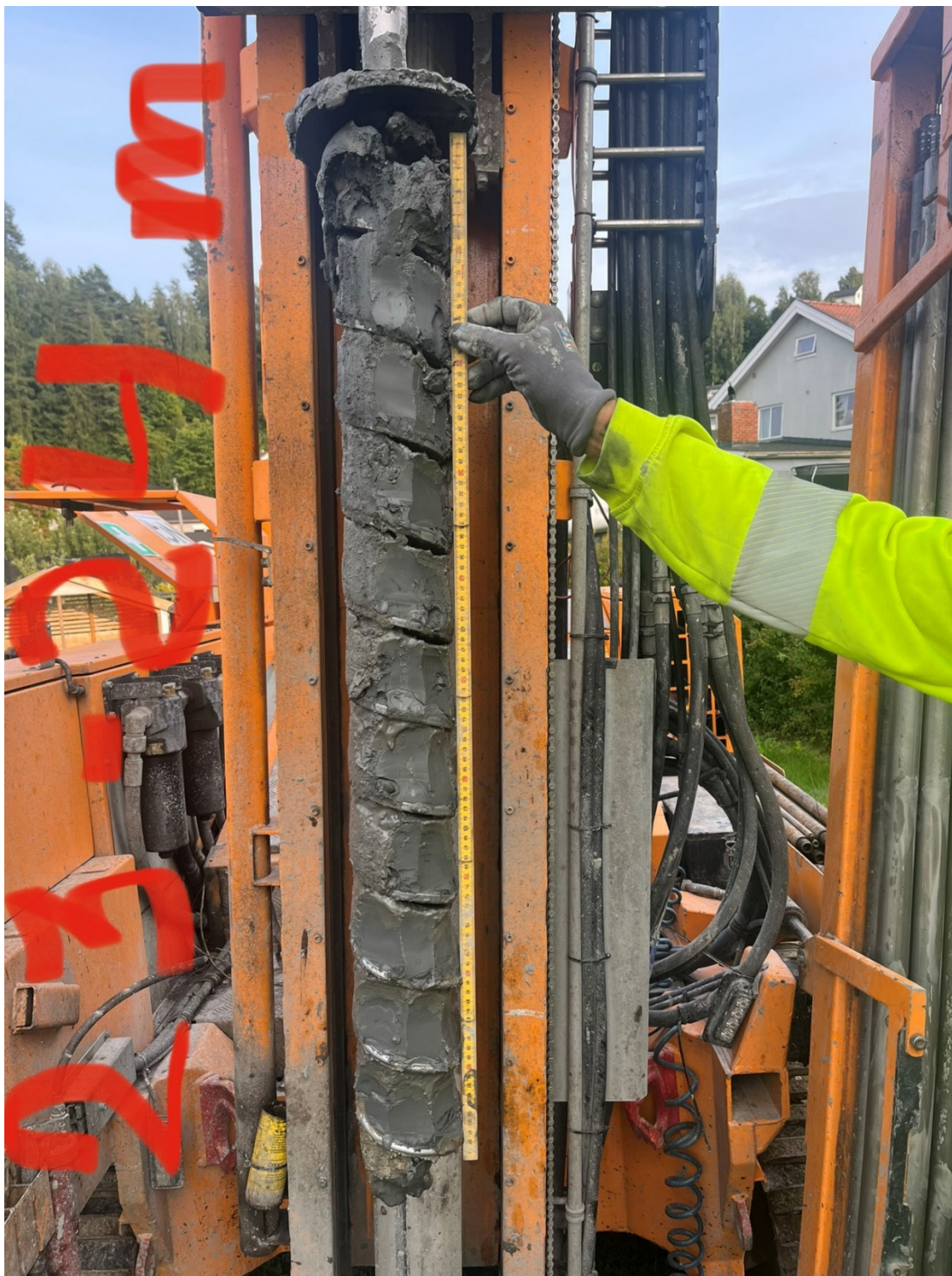
Figur D 7: Skovlboring ved 23-24 meters dybde i borpunkt 2A
