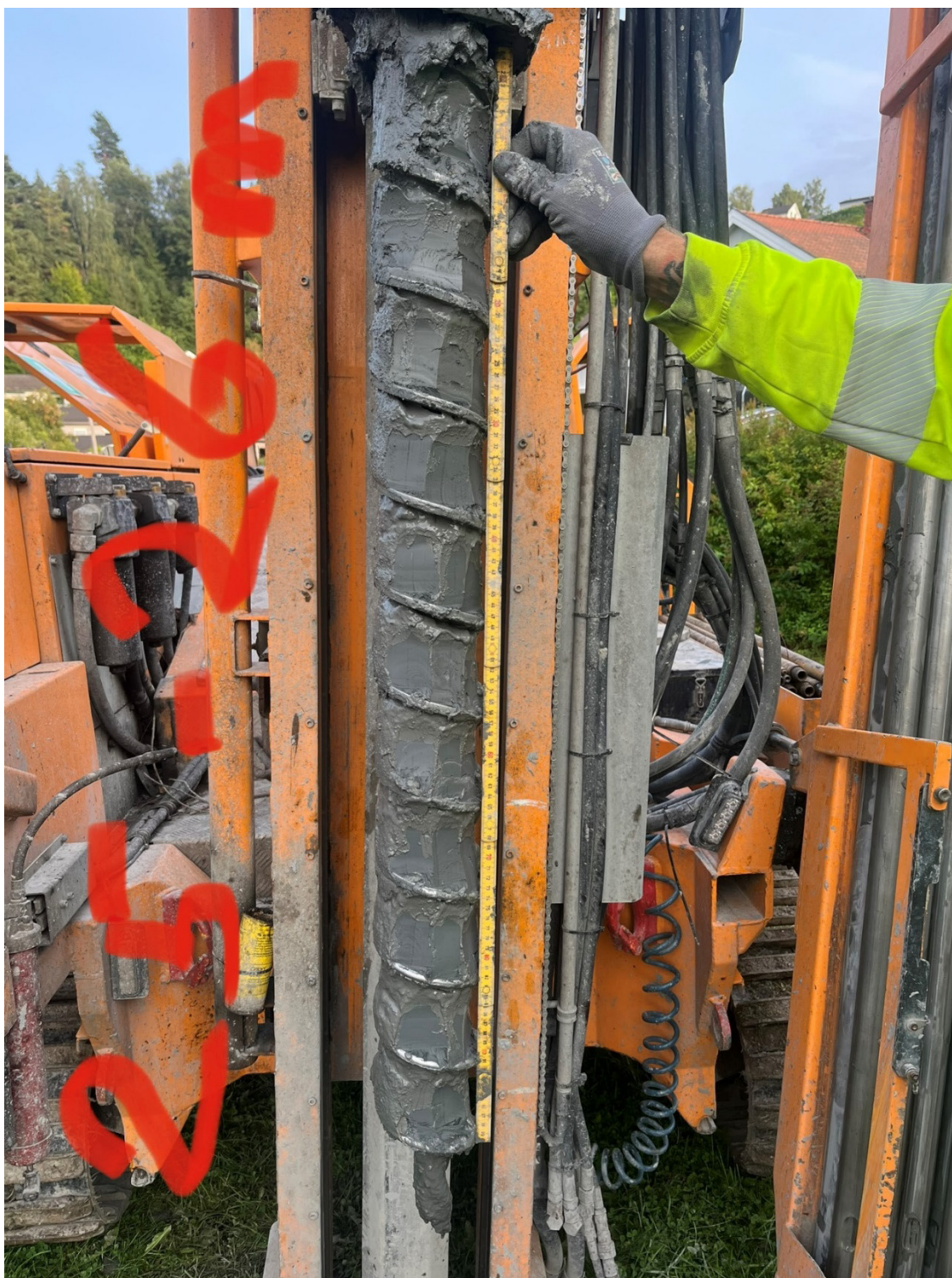
Figur D 9: Skovlboring ved 25-26 meters dybde i borpunkt 2A
