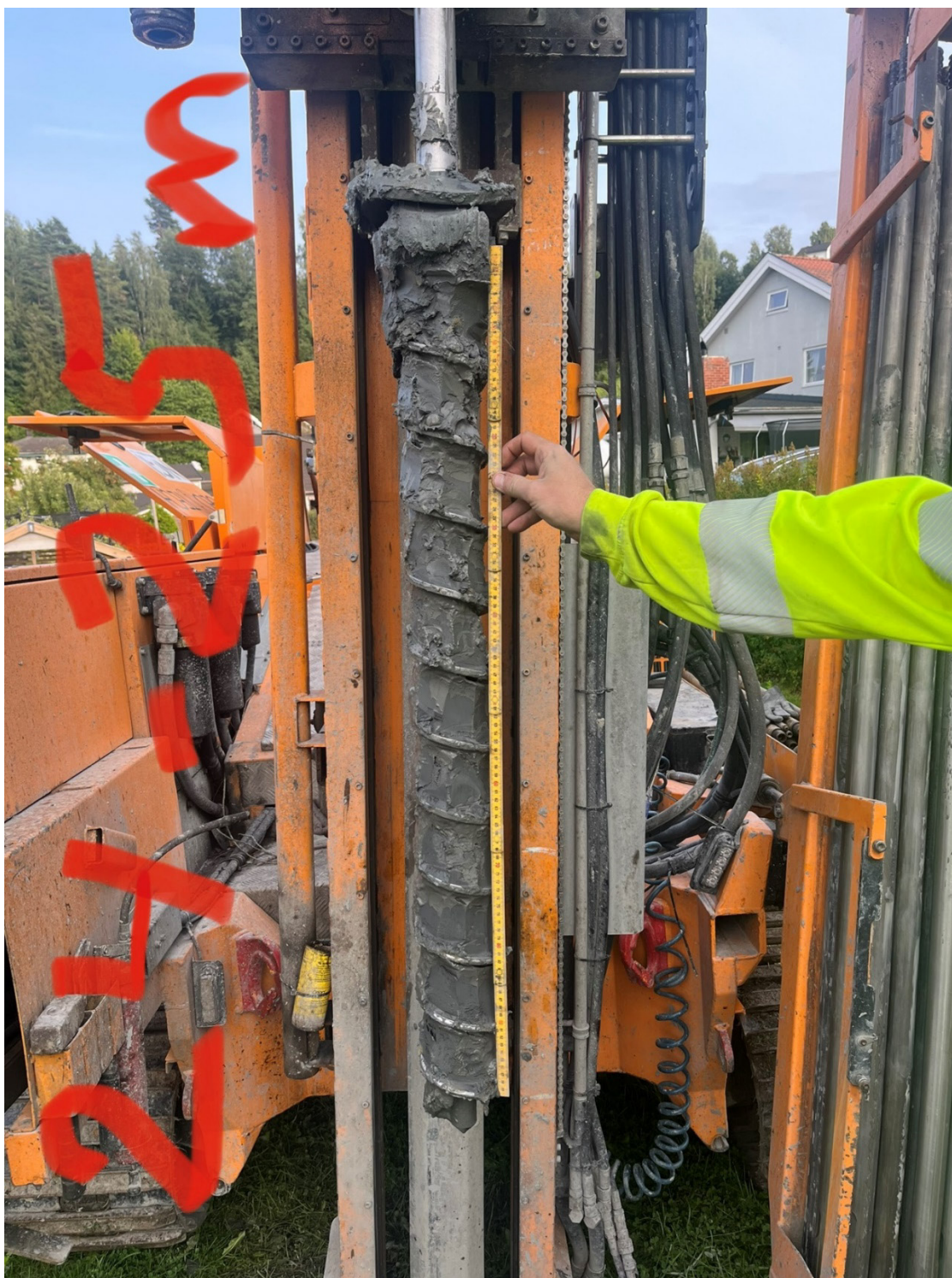
Figur D 8: Skovlboring ved 24-25 meters dybde i borpunkt 2A
