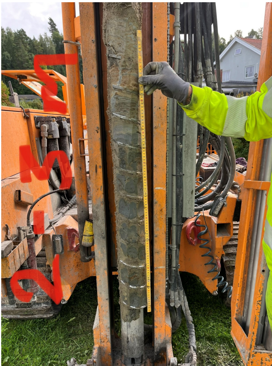
Figur D 2: Skovlboring ved 2-3 meters dybde i borpunkt 2A
