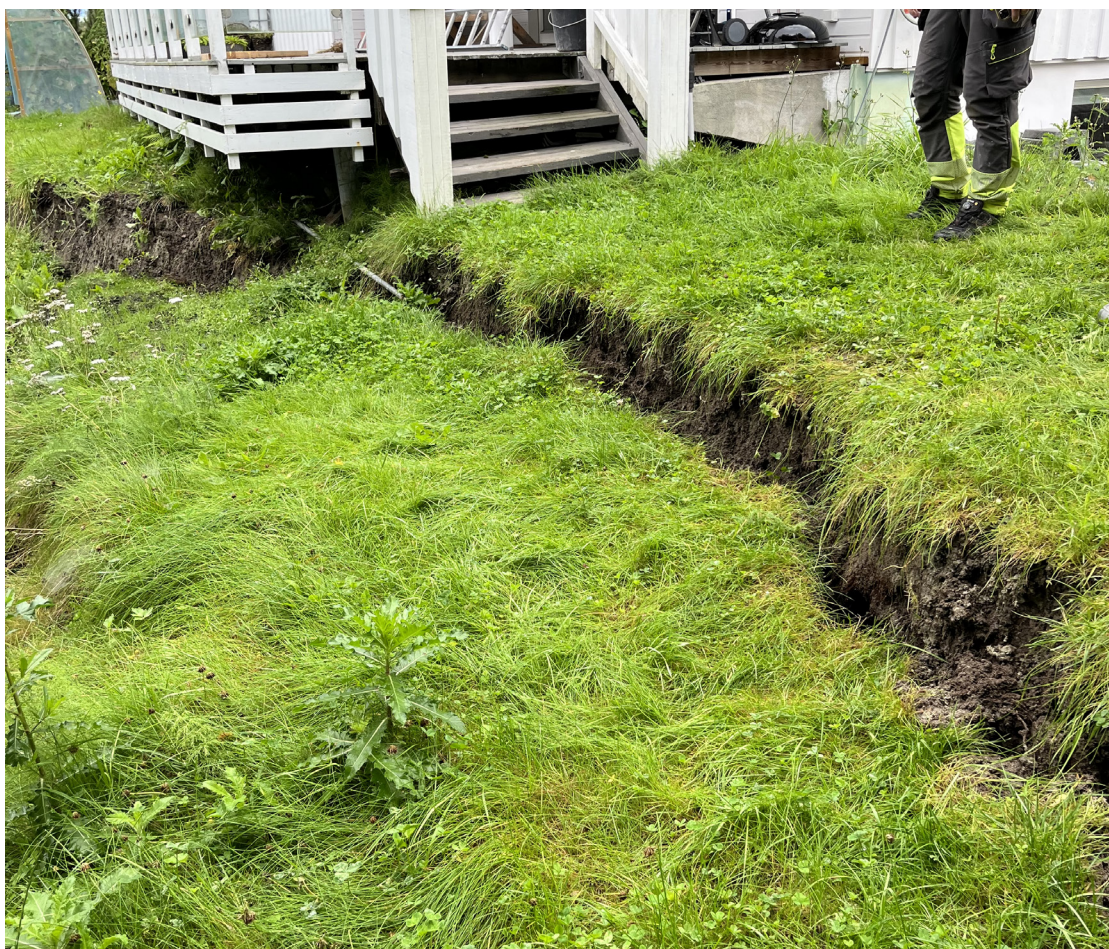
Figur 2: Skredkant like ved borpunkt 2.
