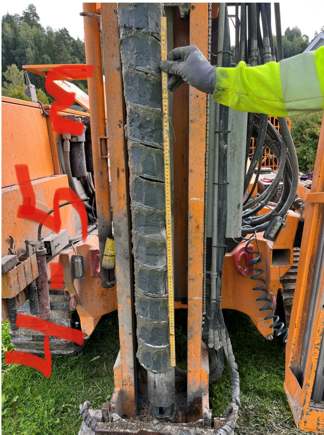
Figur D 4: Skovlboring ved 4-5 meters dybde i borpunkt 2A
