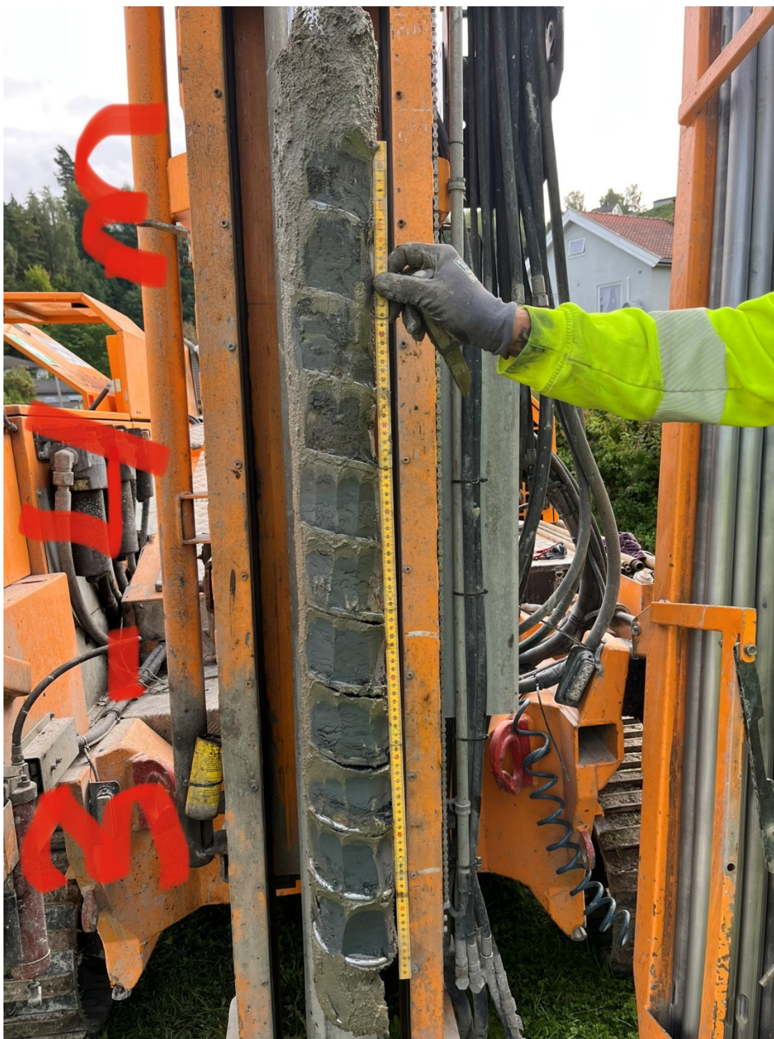
Figur D 3: Skovlboring ved 3-4 meters dybde i borpunkt 2A
