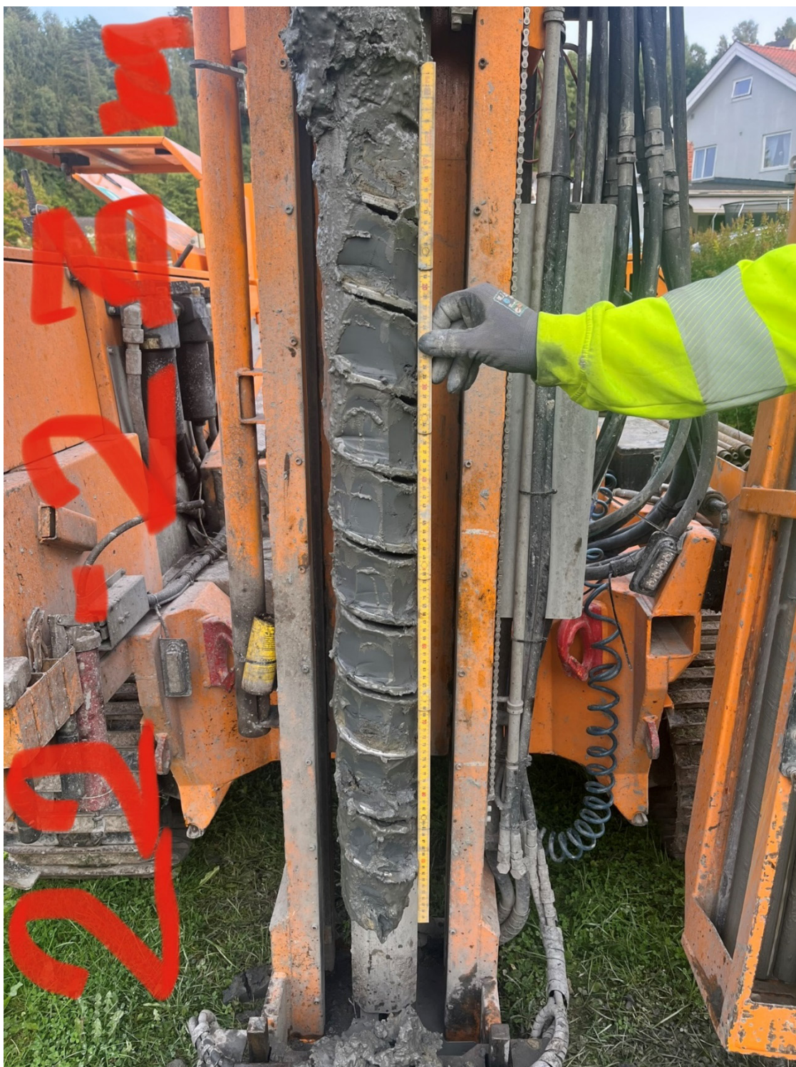
Figur D 6: Skovlboring ved 22-23 meters dybde i borpunkt 2A
