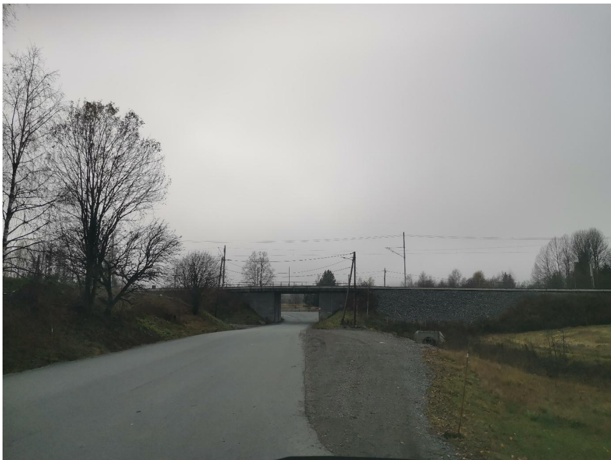
Nordmoveien inn mot kulverten under jernbanen
