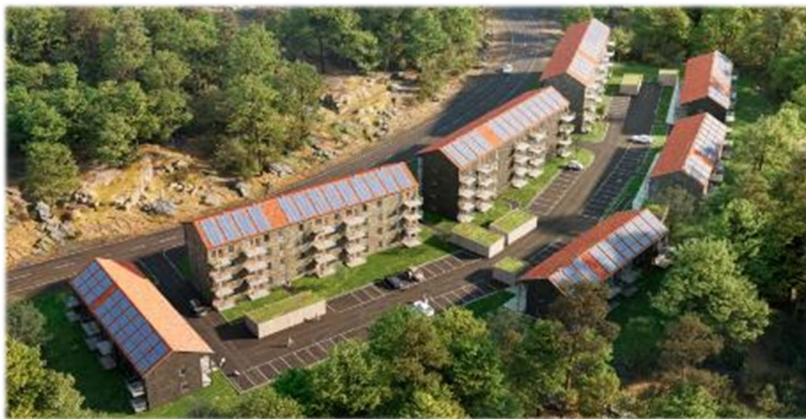
Figur 5-21 Kombinert HYSS-bergvarmepumpe, solfangere og solcellepaneler, Norra Vitsippan [22].
