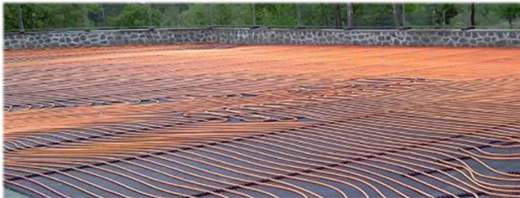
Figur 5-19 Eksempel på bakkesolfanger i TerraLun-prosjektet (Asplan Viak).
