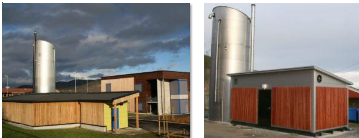
Figur 5-14 Eksempler på utendørs, trepelletsfyrte varmesentraler med bygg for kjelinstallasjon samt pelletsilo med integrert skorstein (venstre – Spongdal varmesentral, høyre – Mosvik skole).
