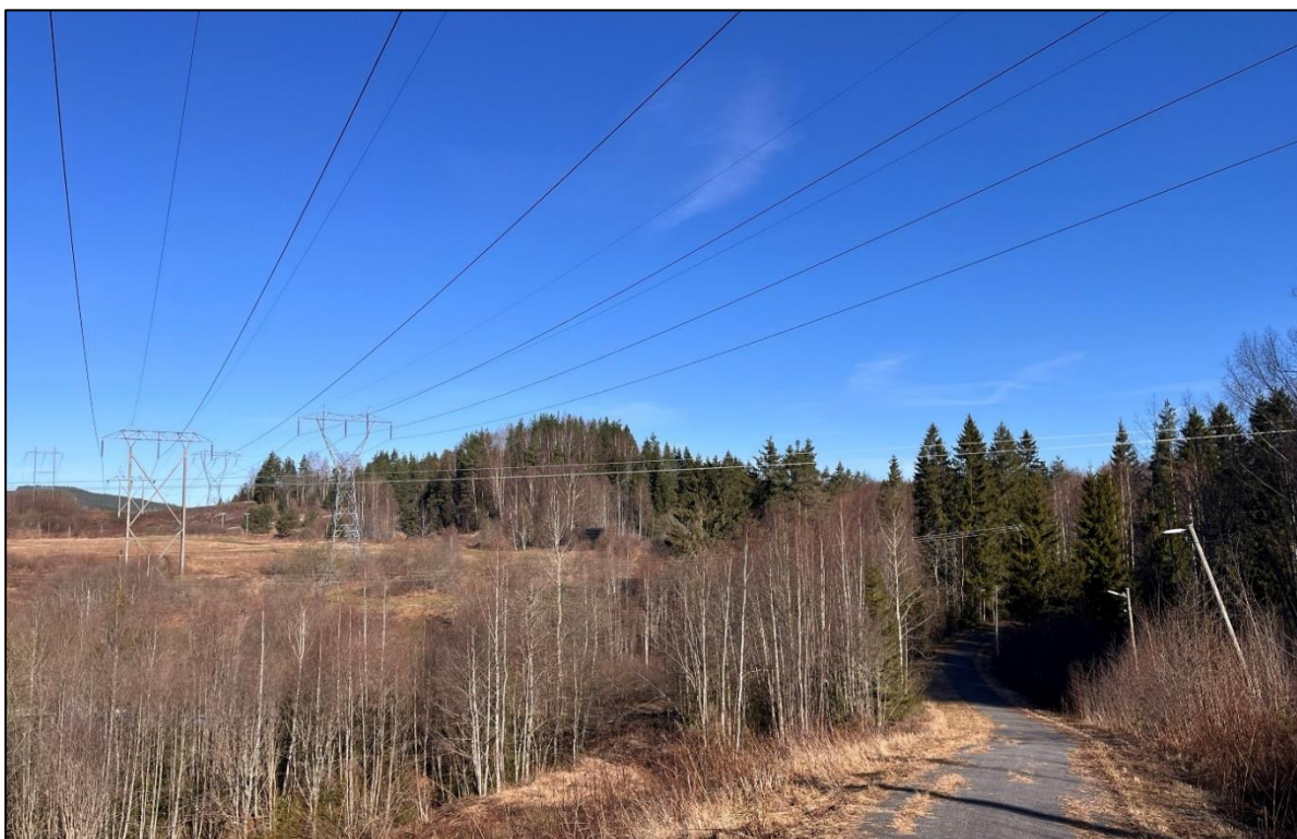
Figur 5-8: Utsikt mot nord, med høyspentmastene godt synlige i landskapet. Eksisterende rulleskiløype i forgrunn.
