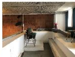
Innkassede ventilasjonskanaler
