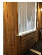
Innkassing radiatorer
