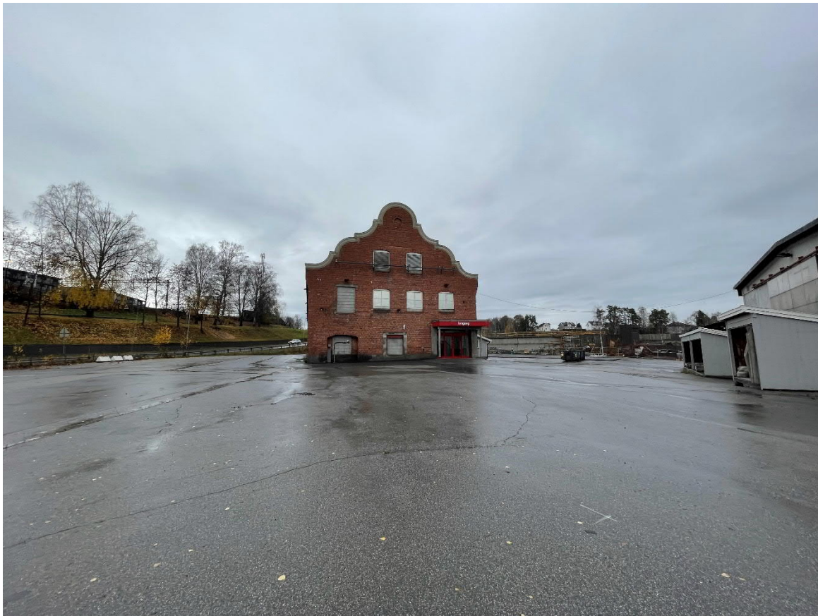
Figur 13: Bilde 6, tatt i nordvestlig retning. Viser Arnemannsveien 7 og omkringliggende asfalterte arealer. Skråning opp mot jernbanen ses oppe i venstre hjørne.
