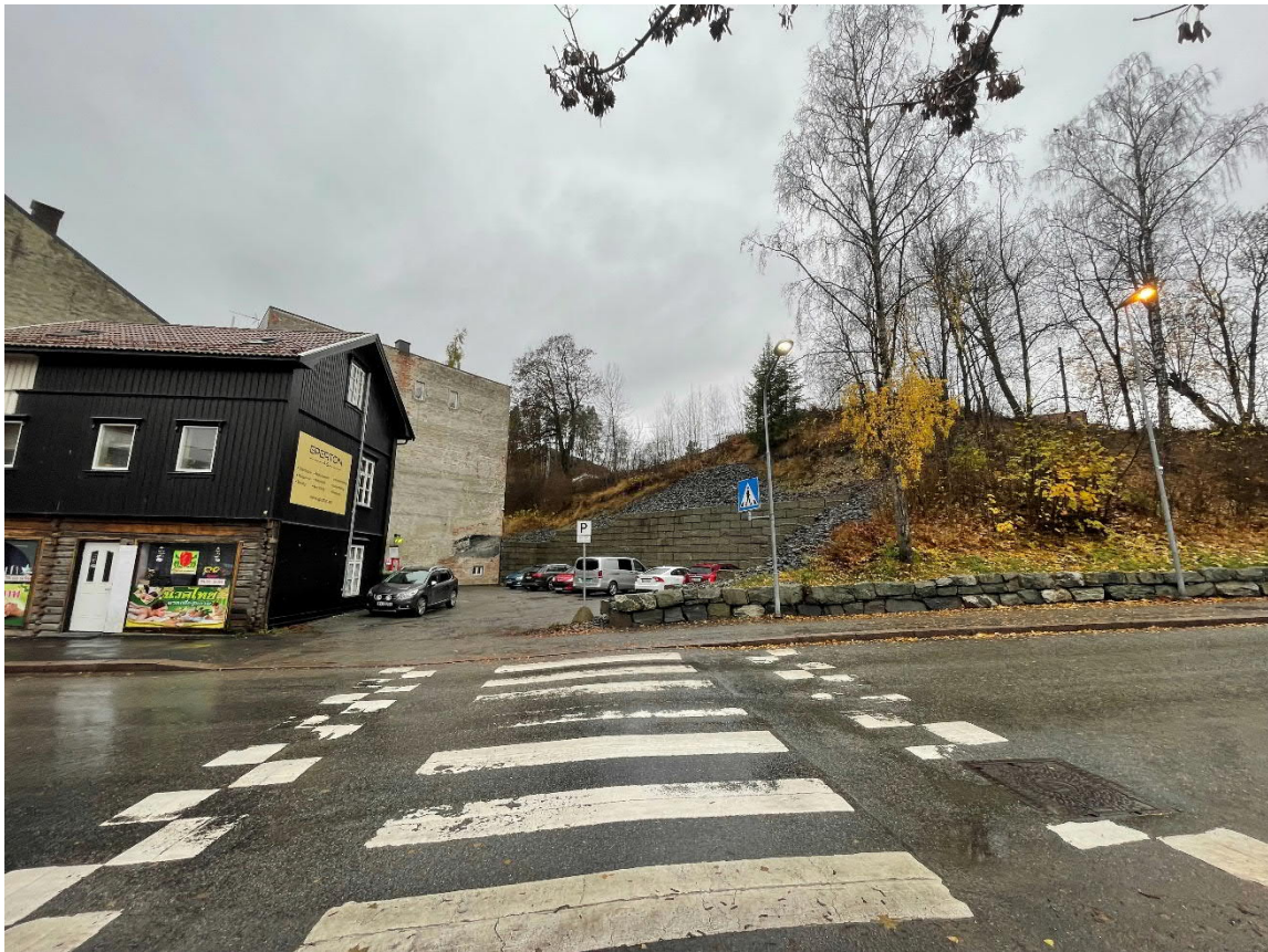
Figur 15: Bilde 8, skråning opp mot jernbanen sett i vestlig (sørvestlig) retning.
