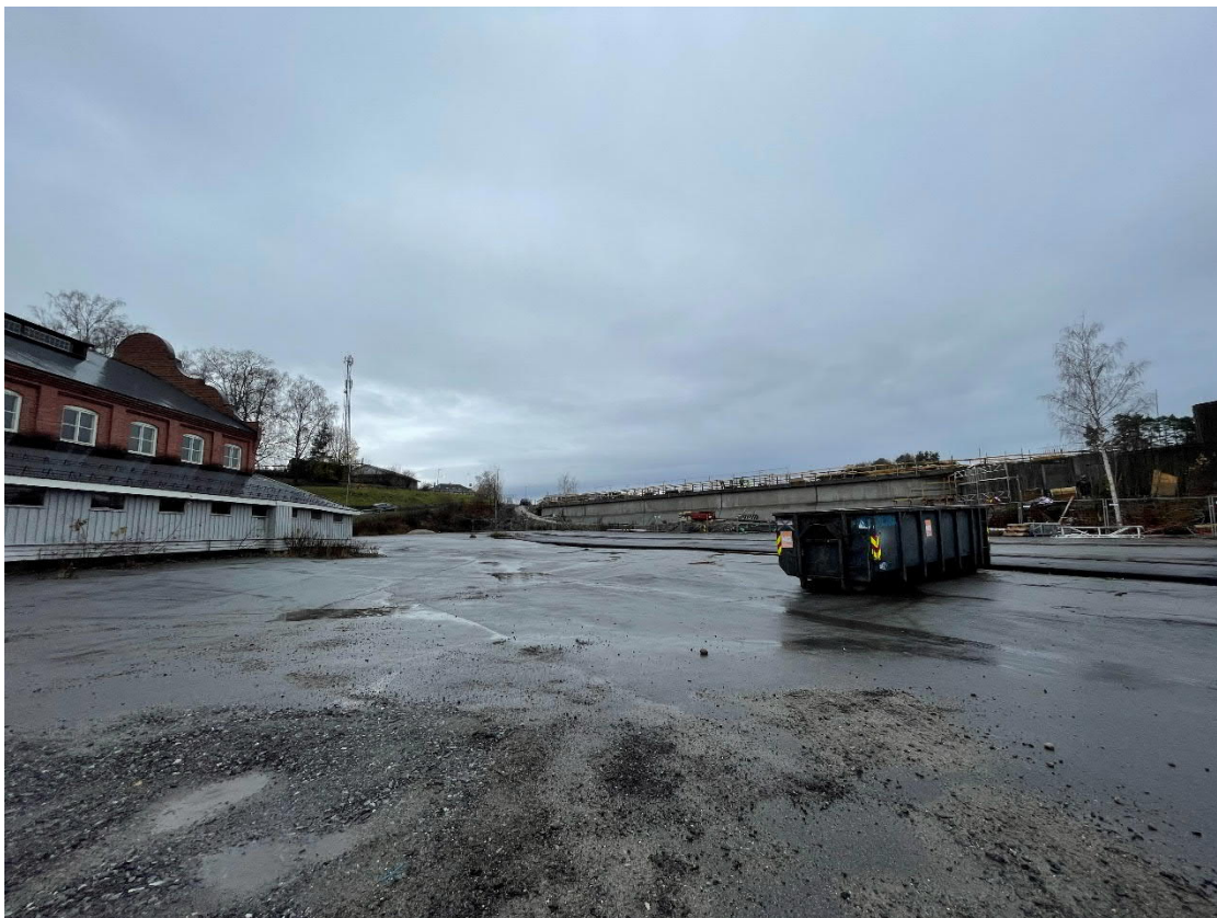
Figur 14: Bilde 7 viser pågående arbeider med demning rett nord for prosjektområdet, Øya.
