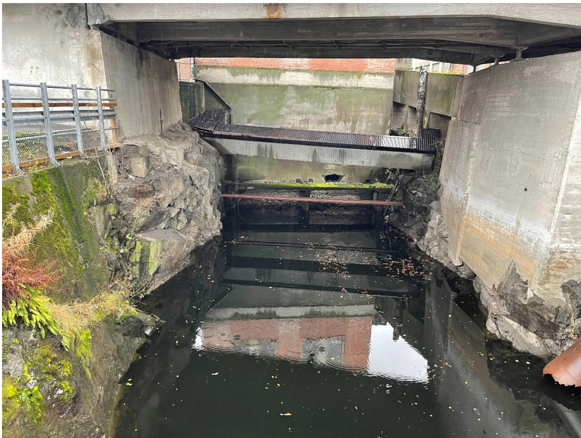
Figur 10: Bilde 3, i vestlig retning, vanntunnel sentralt på parkeringen like øst for tiltaksområdet.
