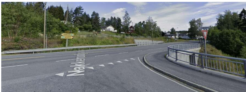
Krysset Nakkerudgata – Vikersundveien.
