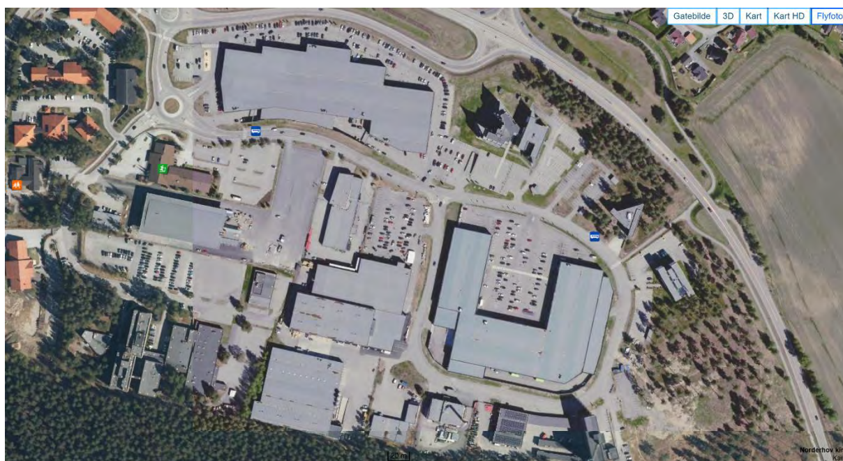
Figur 3-1. Oversikt over eksisterende bebyggelse (foto: finn.no)
