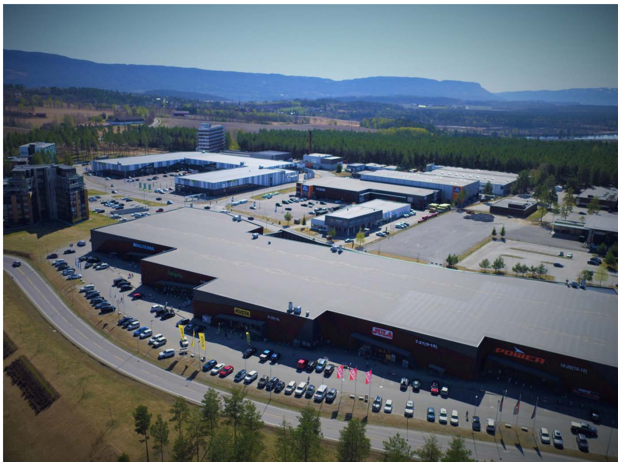
Figur 12 – Dagen situasjon. Handelsbygg innenfor HM2 i front, HM49 til venstre i bildet, og HM60, HM11 og 15 i bakkant. Her fremkommer areal for utviklingspotensialet for HM7 og KV6 og 7 til høyre i bildet.
