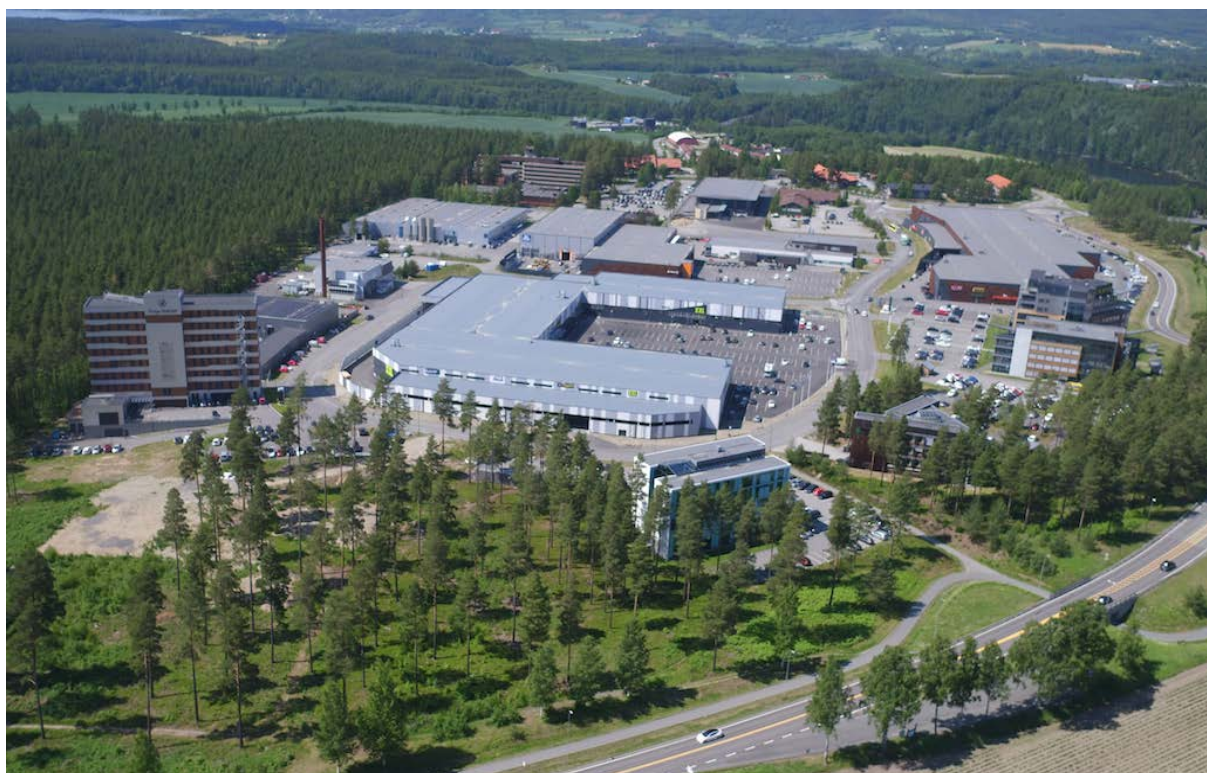
Figur 14 – Dagens situasjon. Området sett fra øst. Kontorbygg innenfor HM33 til venstre i bildet, HM60 sentralt og kontorbygg HM45, 47 og 49 til høyre i bildet.
