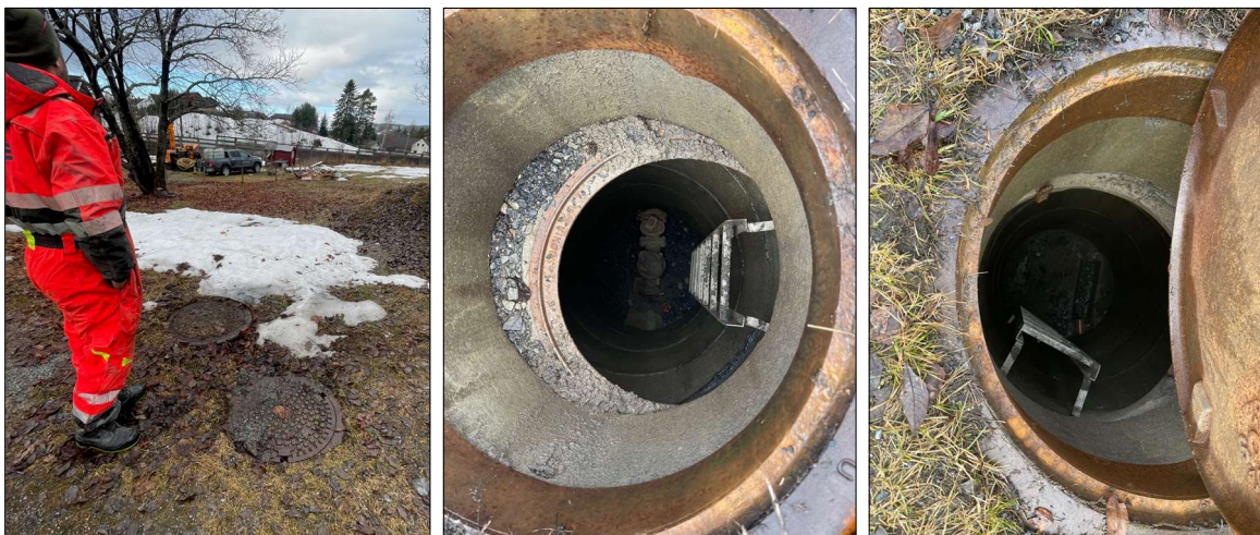
Figur 6: Bilder fra utført befaring som viser observerte kummer. Bildet i midten viser vannkummen og bildet til høyre viser spillvannskummen (Brødrene Myhre AS, 12.04.2023).
