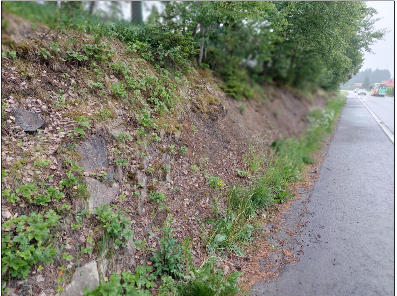
Sørside av Klekkeneveien
