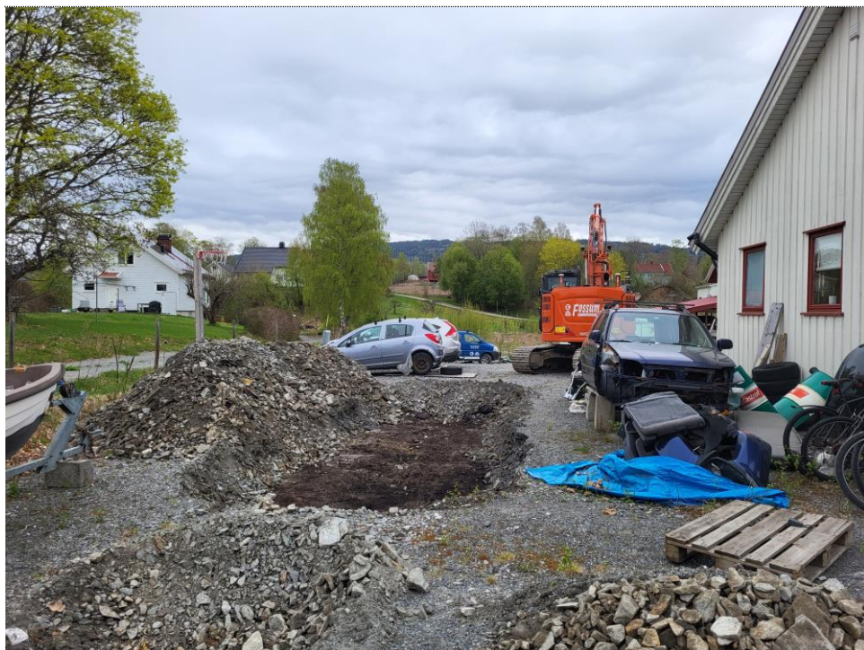
Figur 5. Planområdet i vest med sjakting, sett mot øst.
