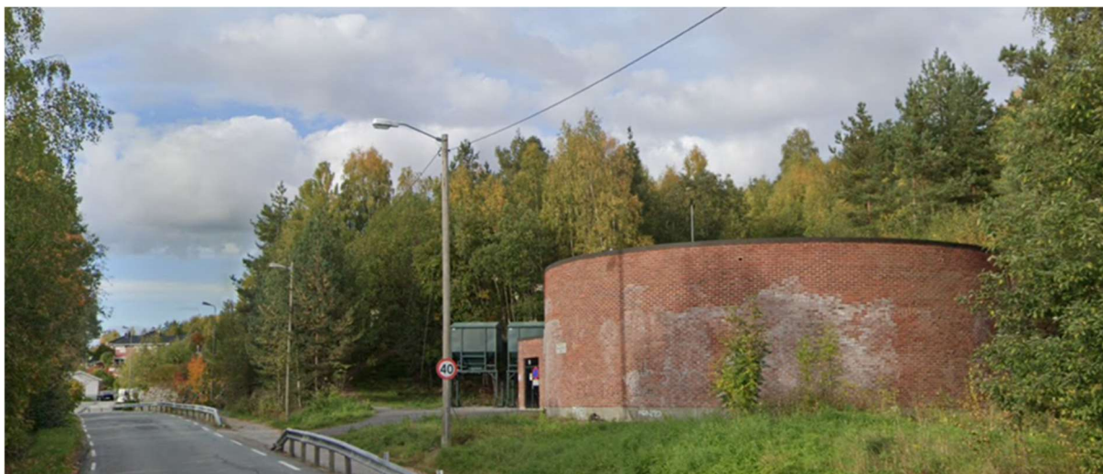
Figur 12: Vanntårnet nedenfor planområdet er oppført i rød teglstein, og fungerer som et landemerke langs Heradsbygdveien.
