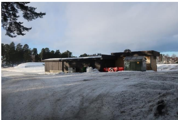
Figur 10. Dagens driftsbygg og trafo midt i planområdet. Kilde COWI, februar 2023.
