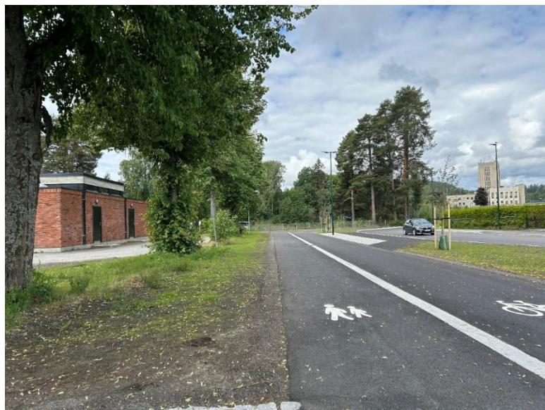
Figur 20. Ringeriksgata med separate anlegg for gående og syklister, juni 2024. Foto: COWI AS
