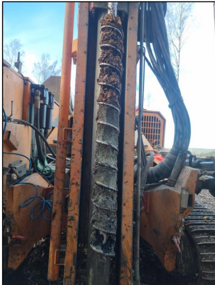
Figur 14: Naverboring fra WSP114 - 3 - 4 m.
