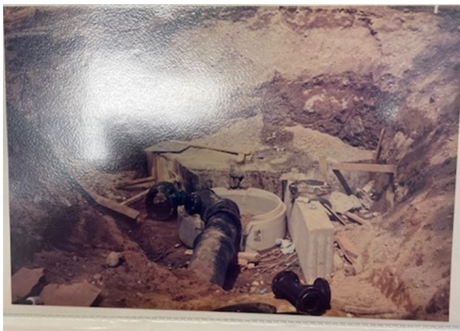
Figur 2.8 Tilsendt bilde av utgraving fra kommunen.
