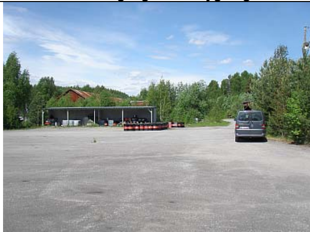
Bilde 4. Kjemikalielageret sett fra sør.
