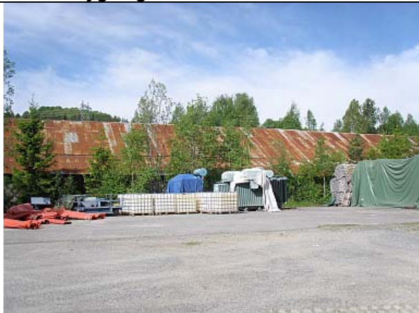
Bilde 3. Bygning A sett fra øst med tomme IBC containere og transformator til høyre om dem.
