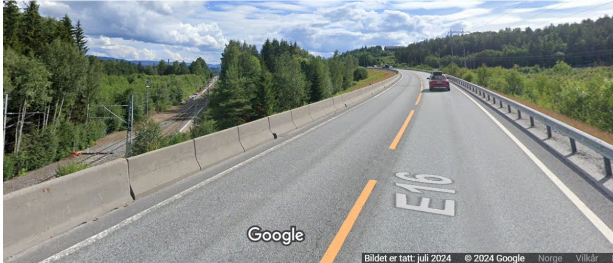
Bilde 1 - E16 i sørlig retning forbi den nordlige delen av planområdet til Begnaparken boligområde. Planlagt bebyggelse ligger ca 110 m øst for E16 i dette området.
