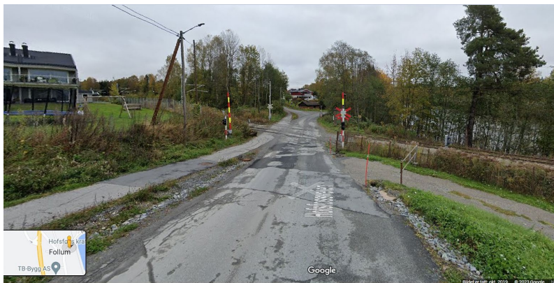
Bilde 7 – Planovergang Randsfjordbanen / Hofsfossveien (Kilde: google maps)
