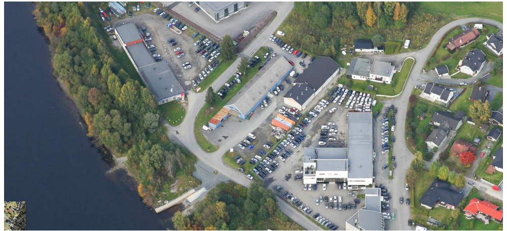
Figur 8 Gigstads vei 7 og 13. Skråbilde sett fra sør (gulesider.no).
