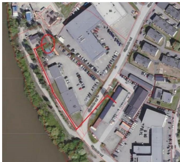
Bilde 4: Flyfoto grøft og trafoplassering (Føie)
