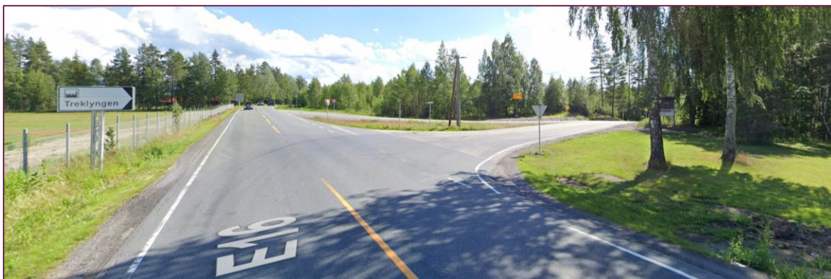
Figur 9: Kryss E16-Ådalsveien, sett fra nord. Bilde tatt juni 2024 (Google Maps)
