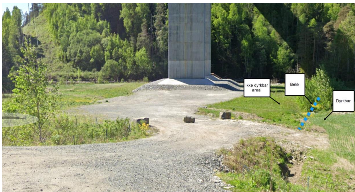
Figur 2-5. Sjøyle til brua over planlagt areal A, sett fra Kistefossveien.
