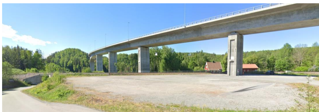
Figur 1-2. Kulverten under jernbanen og E16-brua sett fra Kistefossveien
