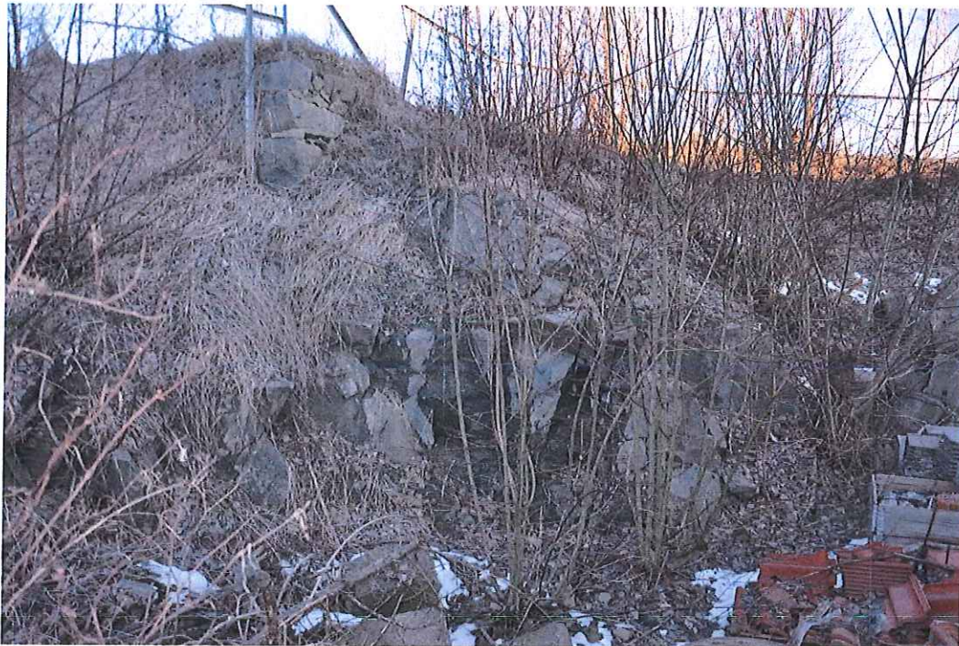
Figur 4. Fotografi av fjell i dagen mellom i vegskråningen mot prosjektert nybygg
