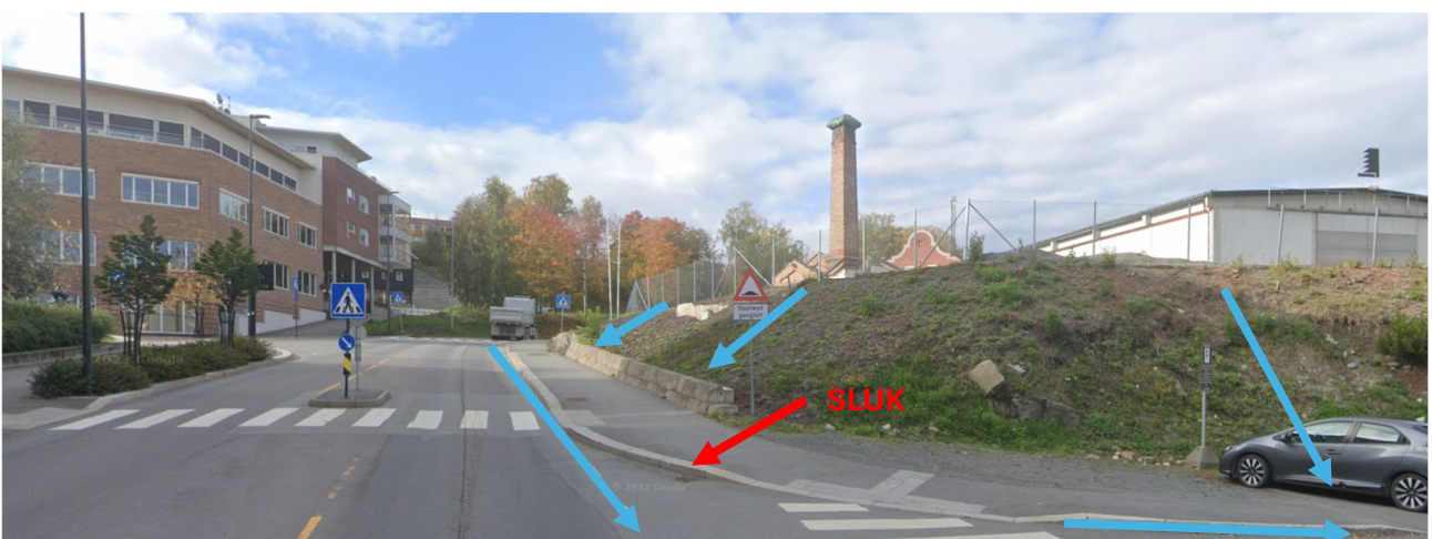
Figur 4: Bilde Arnemannsveien som viser avrenning langs Fylkesveg ved innkjøring planområdet. Ref. googlemaps.
