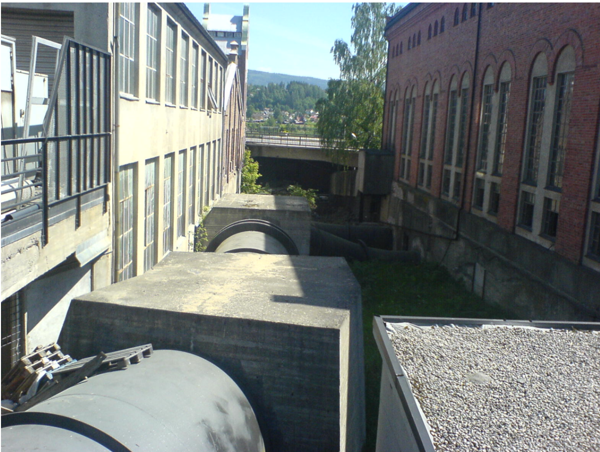
Figur 10: Bilde fra kraftkanal/rørgate som viser lavpunkt gjennom området.
