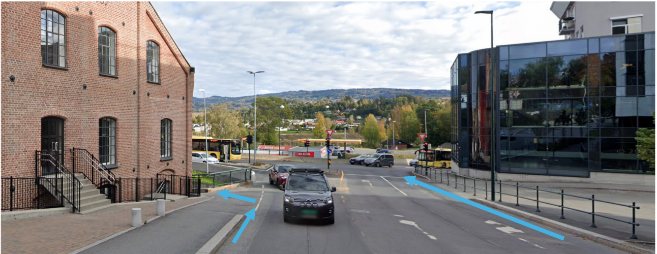
Figur 5: Bilde Arnemannsveien som viser avrenning langs Fylkesveg ved lyskrysset. Ref. googlemaps.
