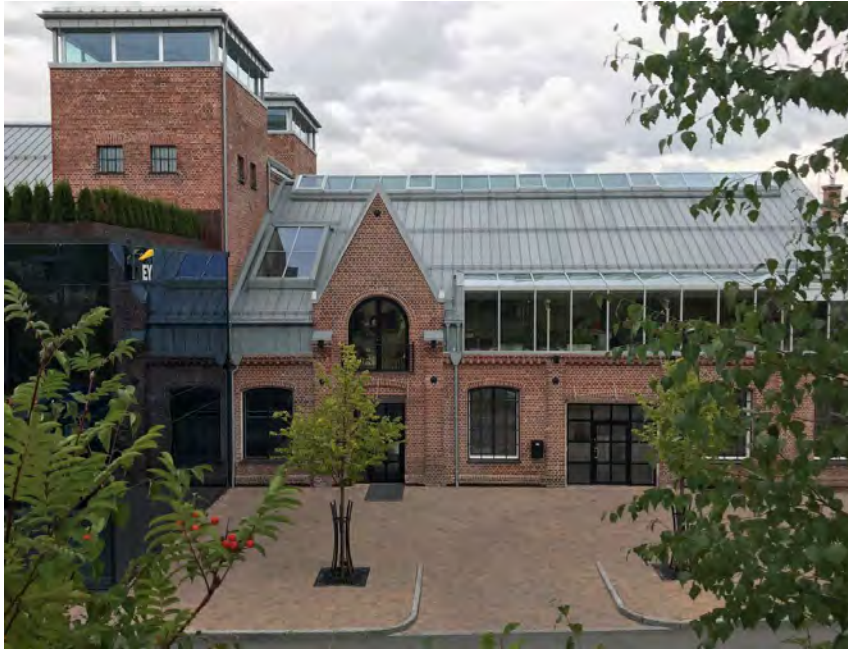
Figur 22: Arnemannsveien 3 etter rehabilitering
