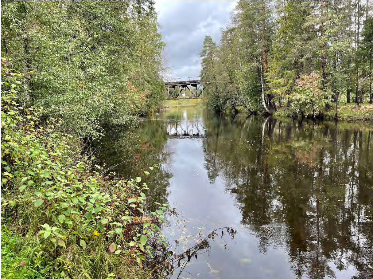
Figur 21: Bilde tatt fra befaringspunkt 1 opp mot jernbanebrua. Skråstilte trær observeres i elvebredden på høyre side/østsiden.
