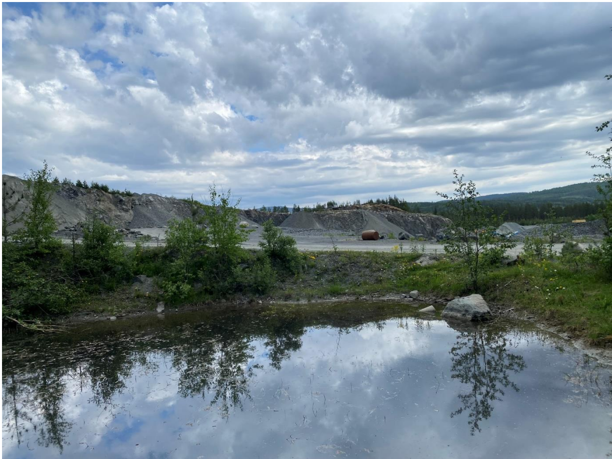
Figur 5. Dam vest for uttaksområdet. Overvann fra driftsareal drenerer ikke mot dammen, men ved større nedbørshendelser kan deler av overvann fra driftsveien renne ned mot dammen.
