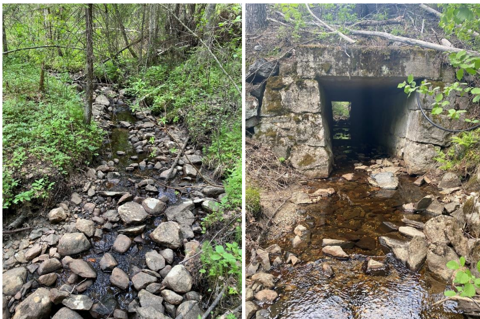
Figur 7. Djupedalsbekken etter samløp med annen bekkearm. Bilde til høyre viser kulvert under Strømsoddveien hvor det er gode muligheter for oppgang av fisk fra Sokna.
