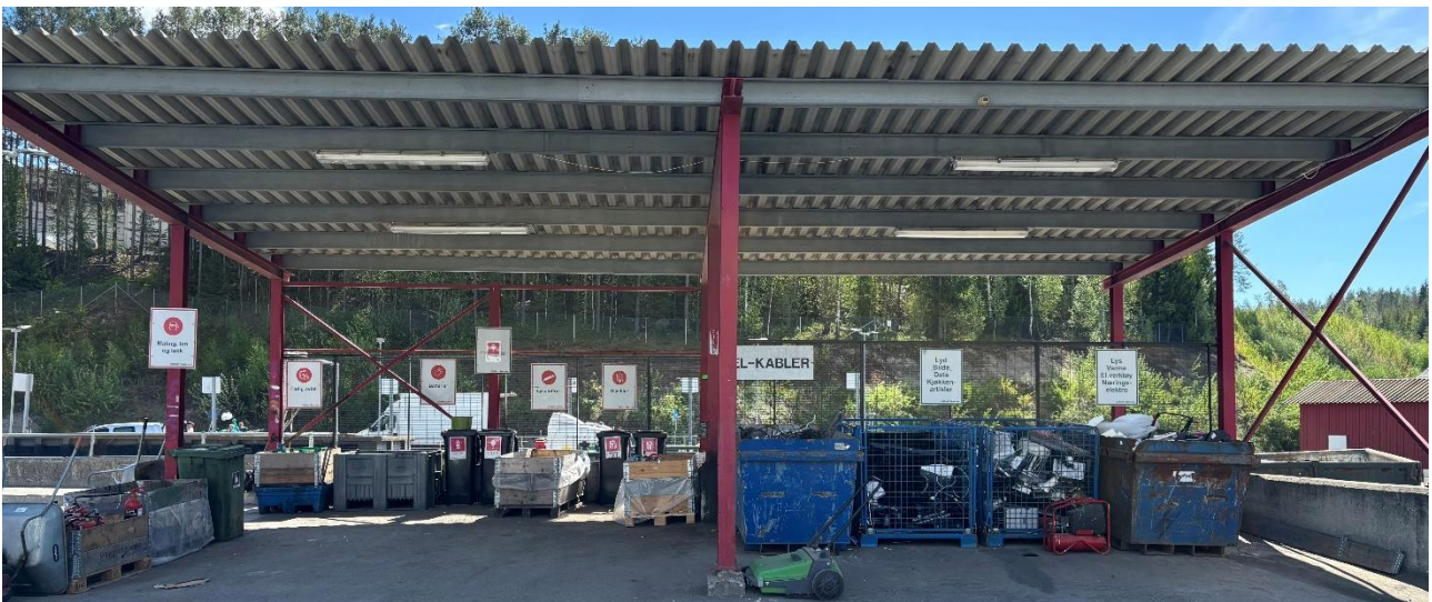
Figur 13: Overbygg ved levering av avfall. Foto: Norconsult Norge AS, 16.05.2025.
